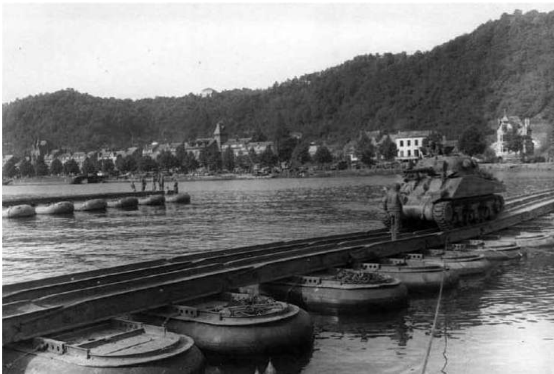
Figure 50. Pour traverser les 150 mètres de la Meuse à Namur, en plus d'une réparation sommaire du pont de Jambes, un pont flottant a été construit entre La Plante et la rue de Francquen à Jambes, à l'endroit actuel de l'écluse, car il fallait supporter au moins le passage de la Force principale qui devait atteindre Liège par la rive sud et celui de la Task Force King pour le centre du Condroz. Vu de Jambes vers l'église de La Plante. © US Army.
