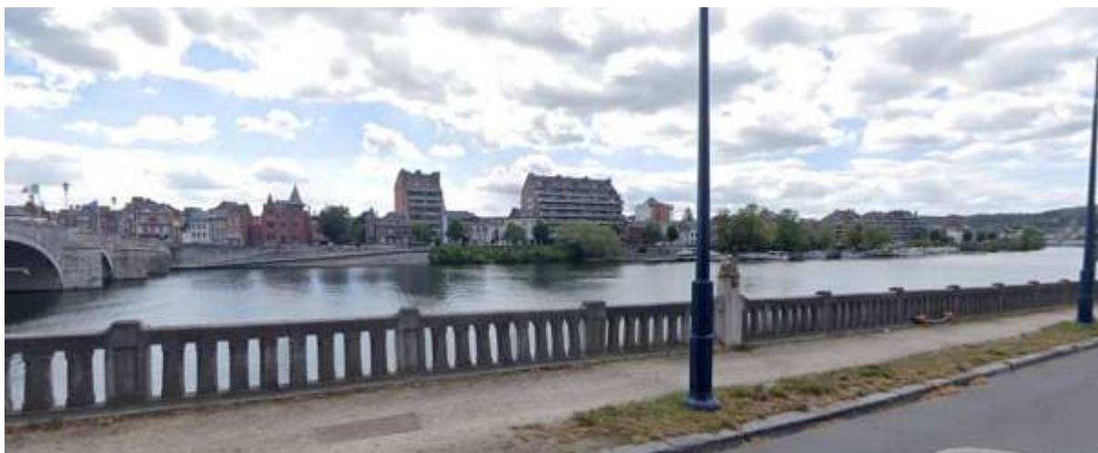
Figure 51. Le pont de Jambes (à gauche) a été complété par un pont Bailey et un pont flottant a été installé à l'endroit de l'actuelle écluse de La Plante (à l'extrême droite sur cette vue), là où la rive est presque au niveau du fleuve. Ce qui ne correspond pas vraiment au dessin réalisé par la 440 e AAA (voir plus loin)... © Google Maps.
