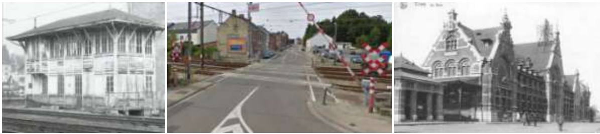
Figure 57. Hormis la traversée d'un chemin de campagne à Gemechenne et le passage à niveau sur une route secondaire suivi de la gare à l'extrémité du village de Braibant, l'endroit le plus probable est à Ciney, au passage à niveau situé entre le Block 44 (cabine d'aiguillages) et la gare. © PFT, RTBF, garesbelges.be
