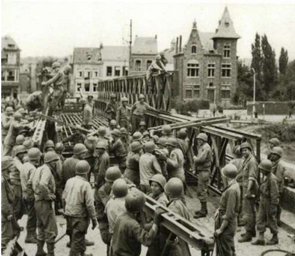
Figure 49. Les Américains jettent un pont Bailey (pont préfabriqué portatif) sur le pont de Jambes démolé. © Canal C.
